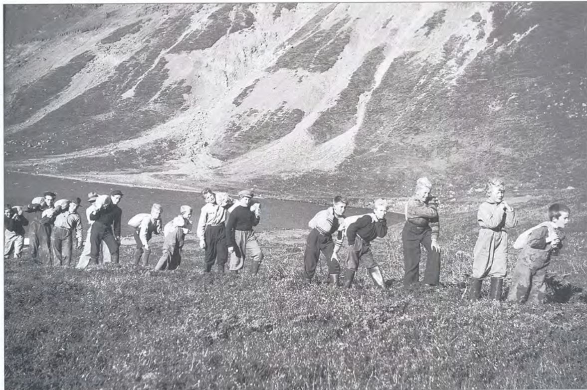
Skálabygging í Krubb 1945. Steypuefni borið í pokum að skálastæði.
